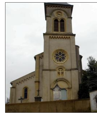
Des travaux seront entrepris à l'église. Photo archives RL
