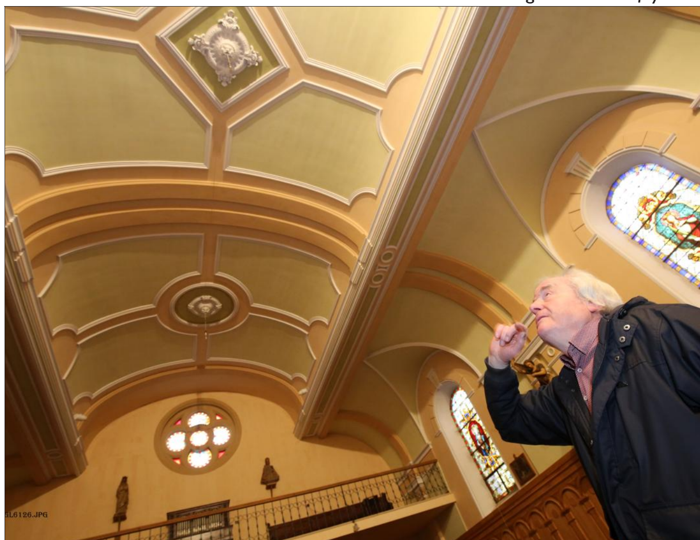
Début 2016 : « Normalement, on avait fini. Je l'ai dit dans mes vœux. Mais il ne l'entendait pas de cette oreille là-haut. La chaudière est tombée en panne ! », note Christian Petit. Photos Gilles WIRTZ
